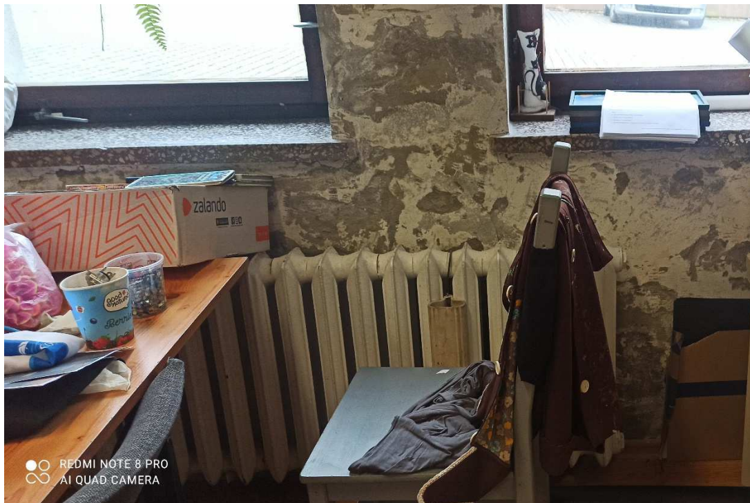
Widok pomieszczenia od środka
